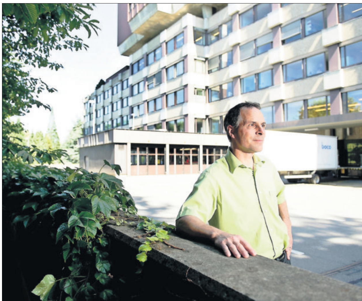
Hier, hinter dem Spital-Hauptgebäude, soll der Anbau zu stehen kommen. Im Bild Adrian Uster, Immobilienmanager des Kantonsspitals. Bild Corinne Glanzmann
